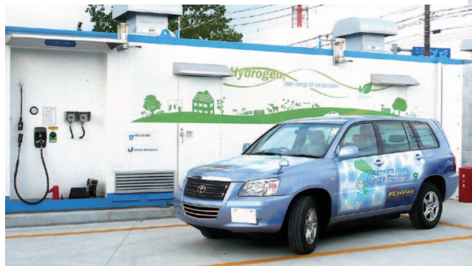
鳥栖水素ステーション(写真提供:佐賀県)
