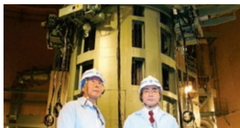
2号機の原子炉建屋内部で、説明に熱心に聞き入る
