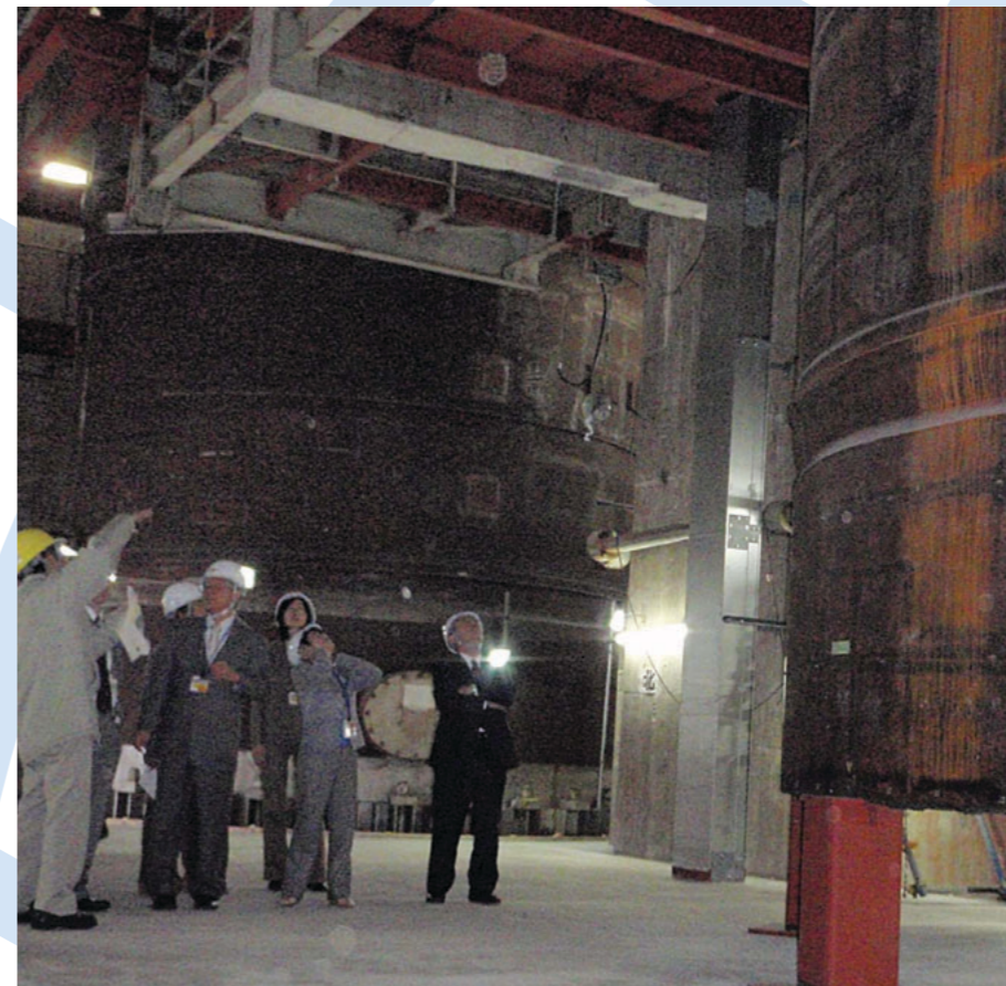
解体中の巨大な熱交換器を見上げる
