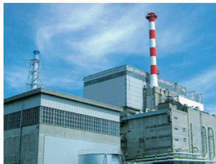
廃止措置が進む東海発電所
