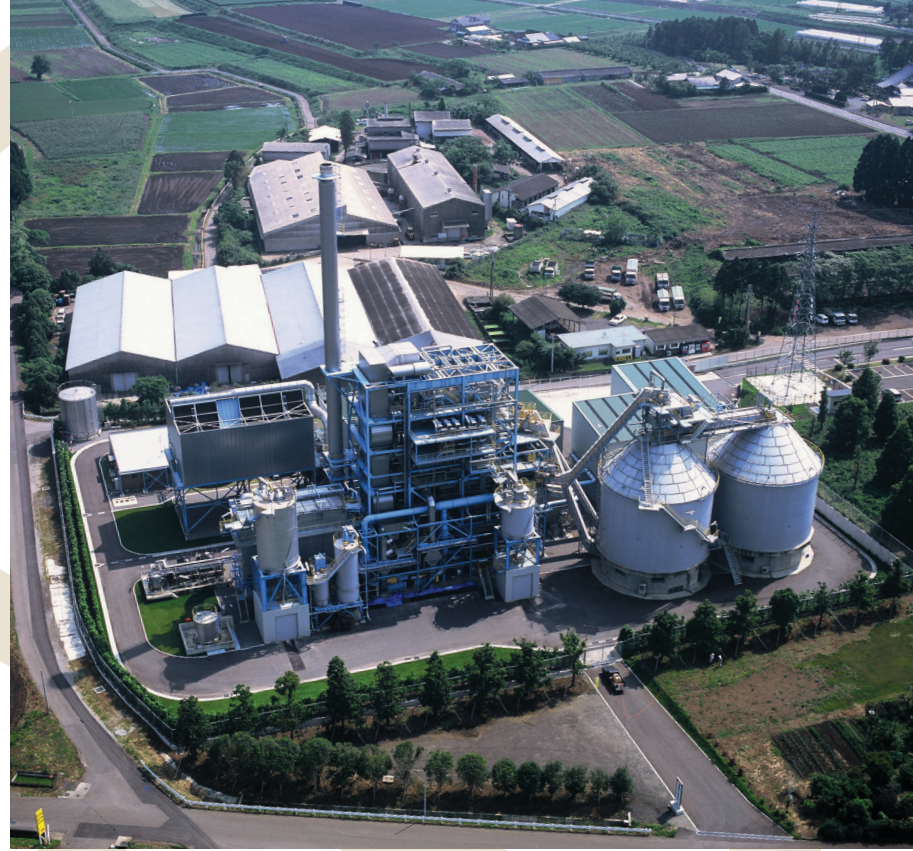
▲みやざきバイオマスリサイクル発電所全景(航空写真)
