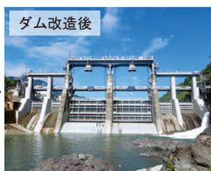
国内初のダム通砂運用を行うために、耳川水系の西郷ダムは約6年半の改造工事を実施し、平成30年8月にリニューアルされた。(九州電力(株)提供)
