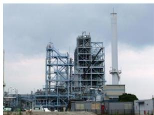
J - POWERでは、石炭の高効率利用とCO<sub>2</sub>低減の取組みとして、EAGLEプロジェクトを推進。これは、石炭をガス化してガスタービン発電を行うと同時に、その排熱を利用して蒸気タービンでの発電も合わせ可能とする「石炭ガス化複合発電」の実現を目指すもので、CO<sub>2</sub>の分離回収試験も実施しています。
