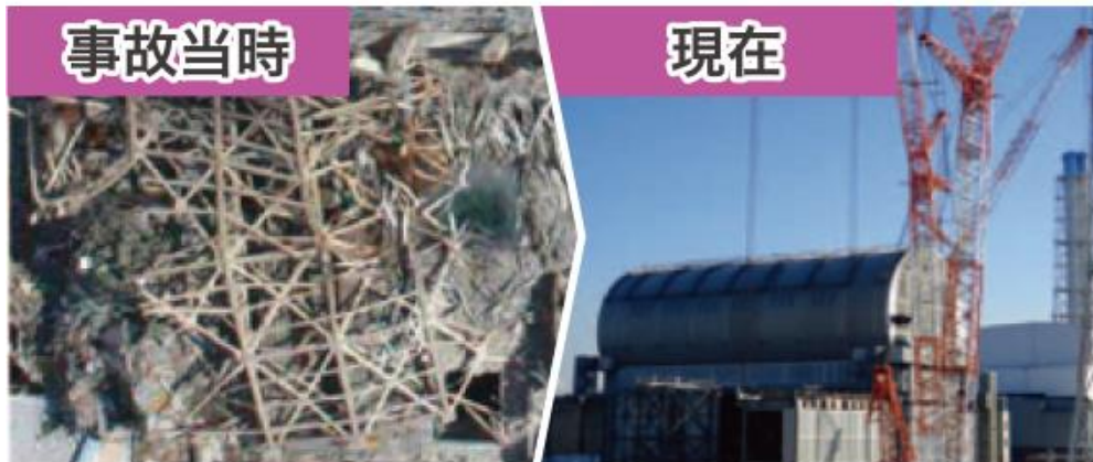
3号機 建屋上部から撮影(事故当時)
